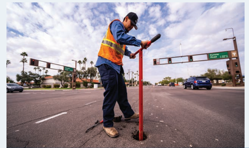
Los técnicos de servicios públicos se aseguran de que las válvulas funcionen adecuadamente, lo que permite que se entregue agua 24 horas al día y limita los cortes de los clientes durante emergencias.
