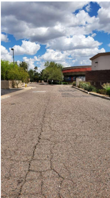
Site Photo 18E
