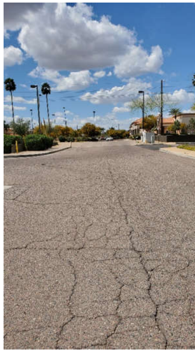
Site Photo 20E
