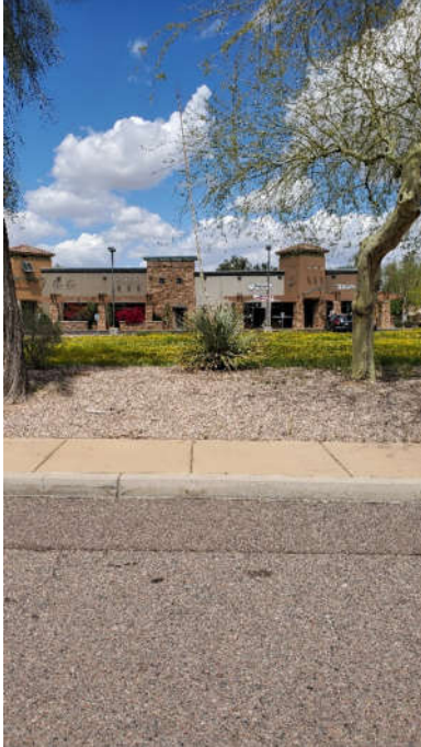
Site Photo 17E
